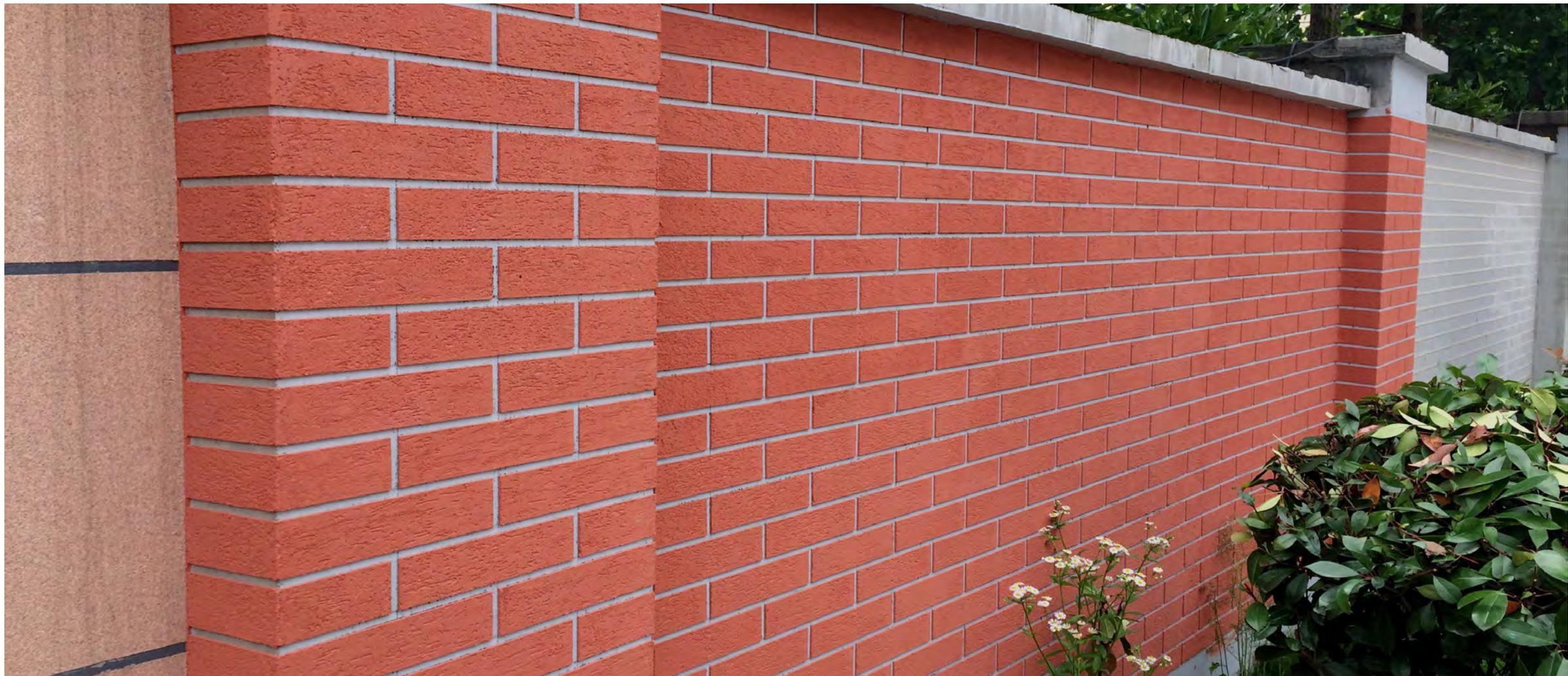
▲厦光无机高级装饰砂浆暴晒实验墙/零泛碱
